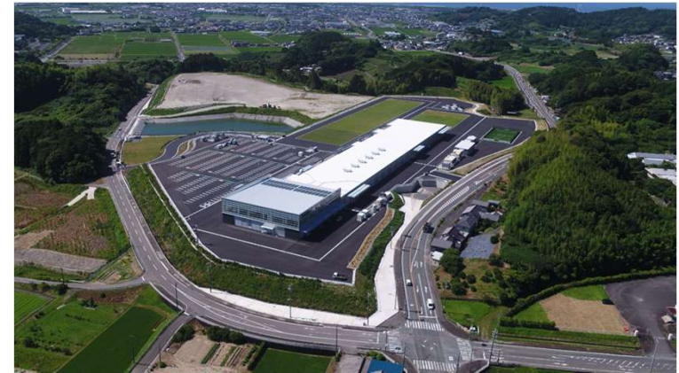
「大坂・土方工業用地 西工区」
