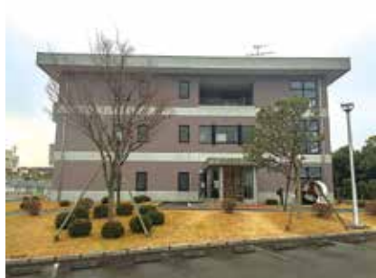
(仮称) 上下水道部が配置される予定の 浄化センター管理棟
