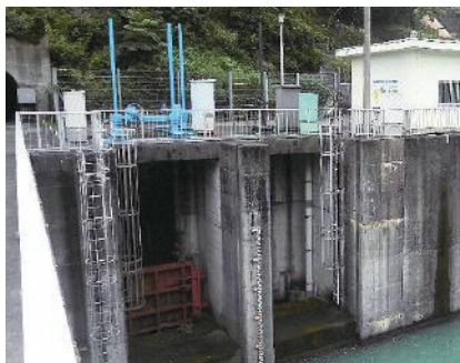
静岡県大井川広域水道企業団 川口取水口
