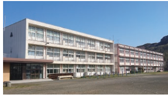
昭和38年建築の土方小学校旧校舎(右)
