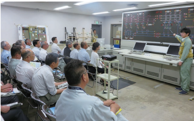
中部電力最大の駿遠変電所
