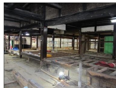
松ヶ岡工事内部の様子
