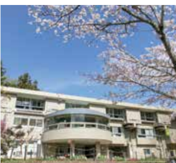
▲令和3年度に外壁が改修されたききよう荘
