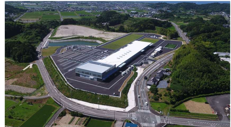
「大坂・土方工業用地 西工区」
