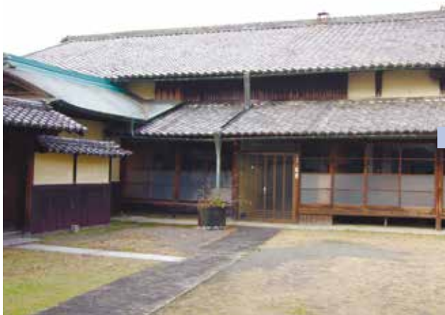
修復前の主屋
