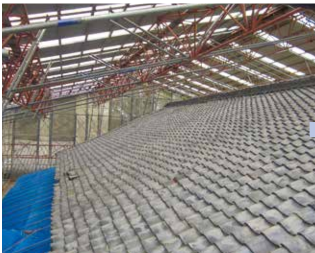
令和2年 解体調査前の主屋屋根
