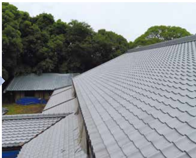
令和5年 瓦の葺き替えが完了した主屋屋根
