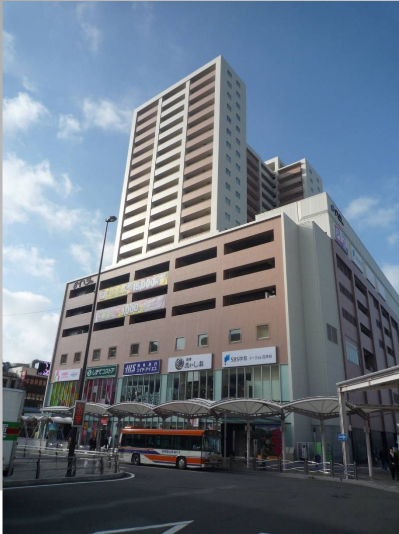
①ビル外観
