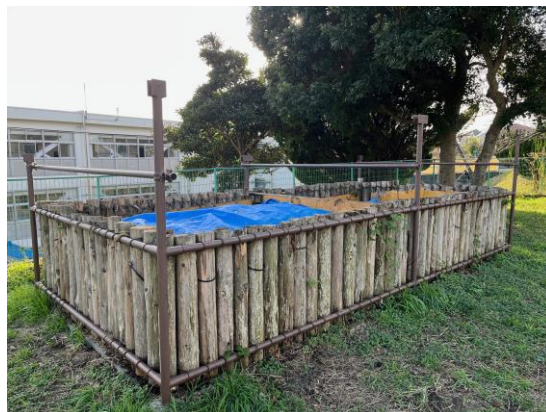
旭ヶ丘区に設置されている 落ち葉等堆肥化設備
