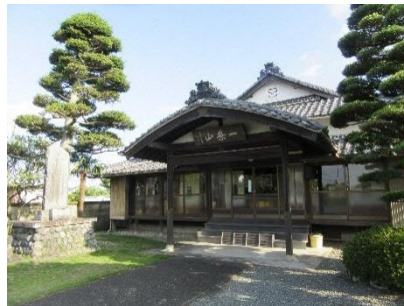
〔建造物〕 蓮祐寺本堂
