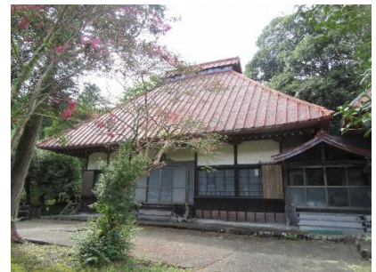
〔建造物〕昌光庵本堂
