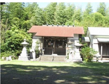
〔建造物〕神明宮 拜殿
