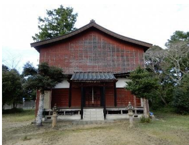
〔建造物〕遠州役行者堂
