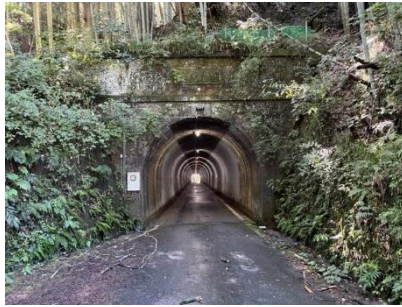
〔建造物〕 岩井寺隧道
