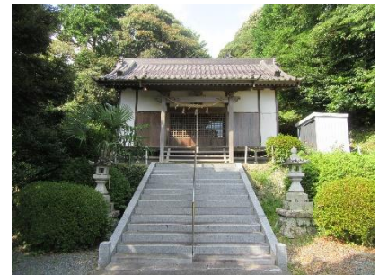
〔建造物〕 池辺神社拝殿
