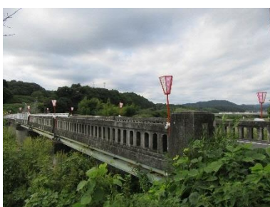
〔建造物〕原谷橋
