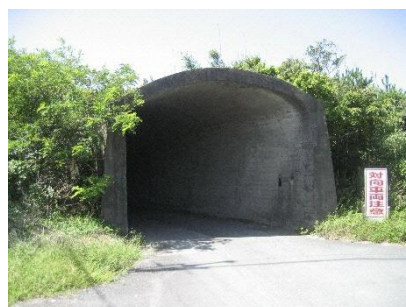
〔建造物〕遠江射場跡内隧道
