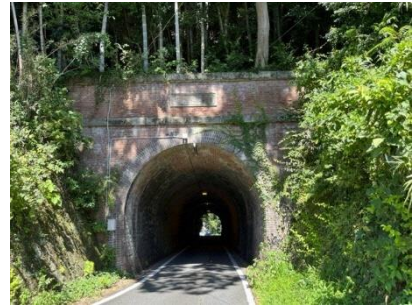
〔建造物〕 桧坂隧道
