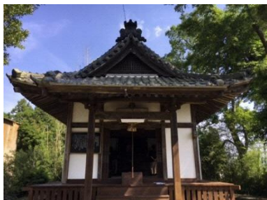
〔建造物〕峰の薬師堂
