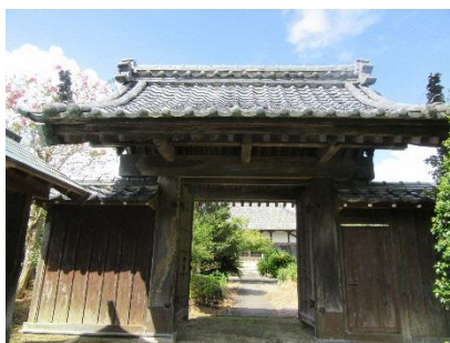
〔建造物〕乗安寺山門
