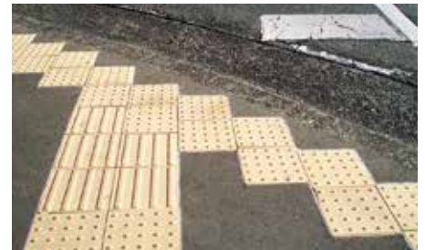
点字ブロック
