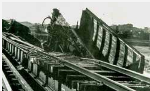
地震によって転ぶくした東海道本線の列車（袋井）
