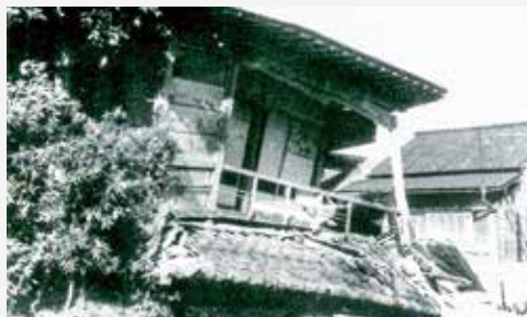
掛川市西町の1階が押しつぶされた家
