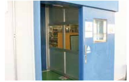
工場の出入り口を二重にして温度としつ度を一定にする
