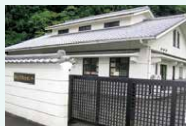
日坂水質保全センター
