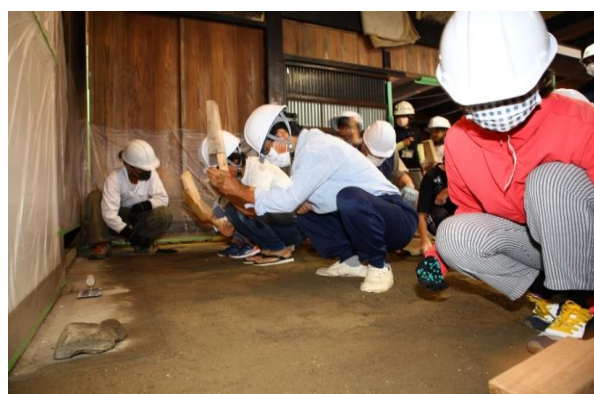
修復工事体験会の様子
