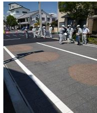
関係課による工事見学
