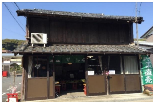
古民家を改修した店舗
