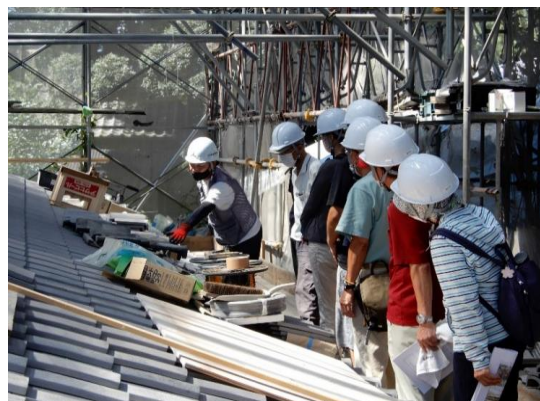
工事現場見学会の様子
