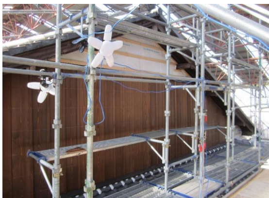
外壁工事の様子
