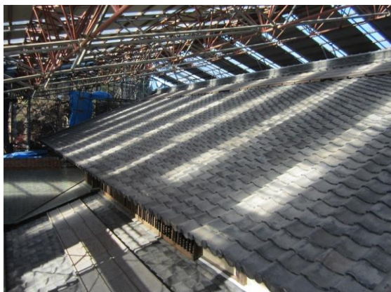
瓦の葺き替え工事が完了した屋根
