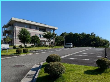
掛川浄化センター管理棟
