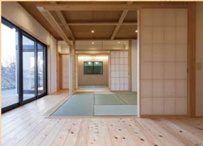
柱・梁・床・障子まで地元材でできた住宅
