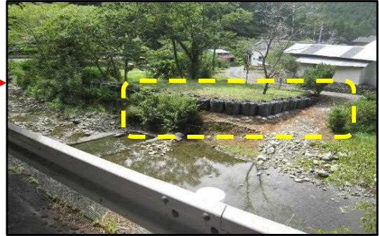
「tバック」を設置し流入を防止
