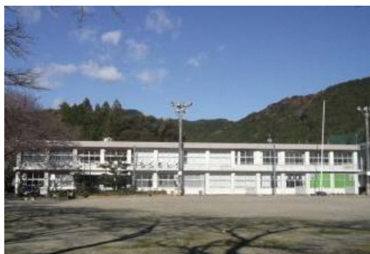
↑旧原泉小学校校舎（静岡県 HP）
