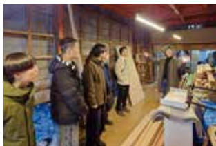
改装中の空き家
