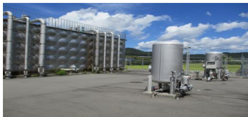
原里浄水場（令和4度改築）
