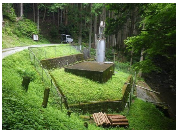
泉簡易水道浄水場
