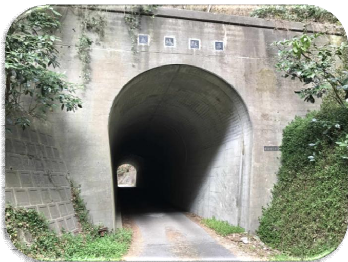
覆工コンクリート（大城隧道※1 市道嶺向東大谷線）
