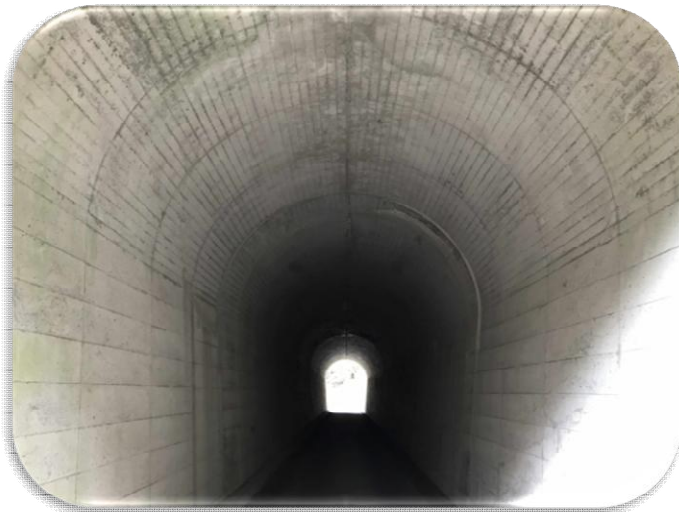
覆工コンクリート（大城隧道※1 市道嶺向東大谷線）
