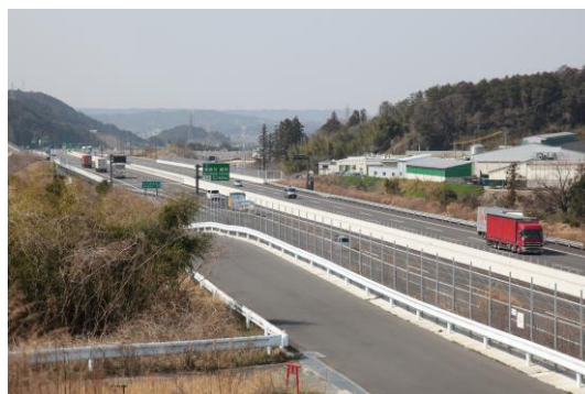
第二東名森掛川インターチェンジ付近
