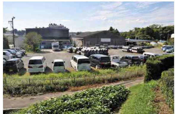
手前はトンネルに続く旧道
