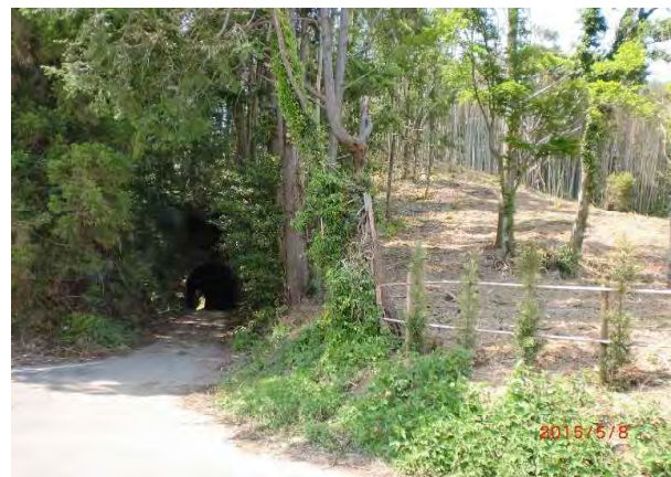
う かり 宇刈に抜けるトンネル(昔は戦闘機の格納庫)
