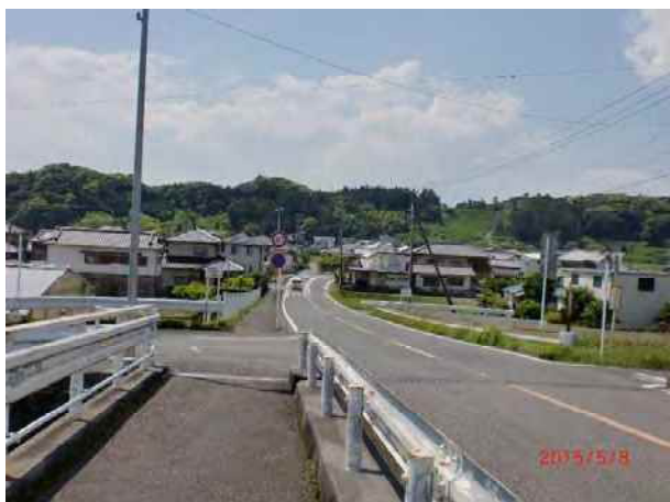
西山橋を渡り西山区へ入った道路左側が市場
