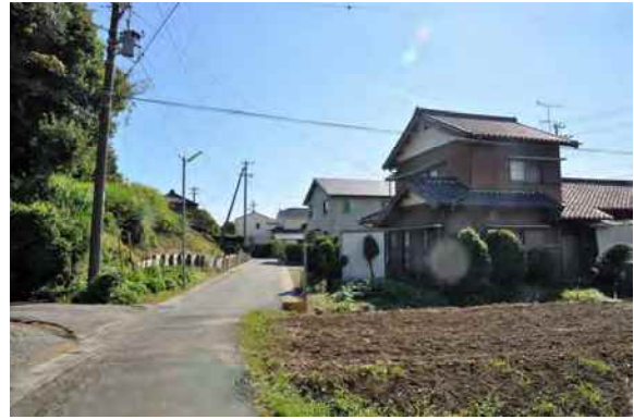
道路工事場所から南を見る
