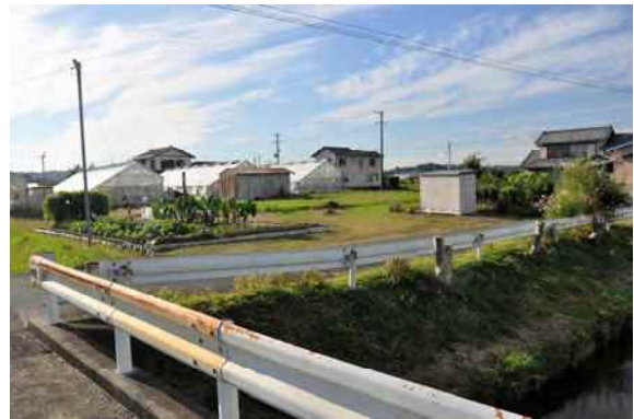
松向橋から北西側を見る
