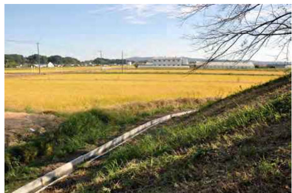
堤防から南東側を見る
