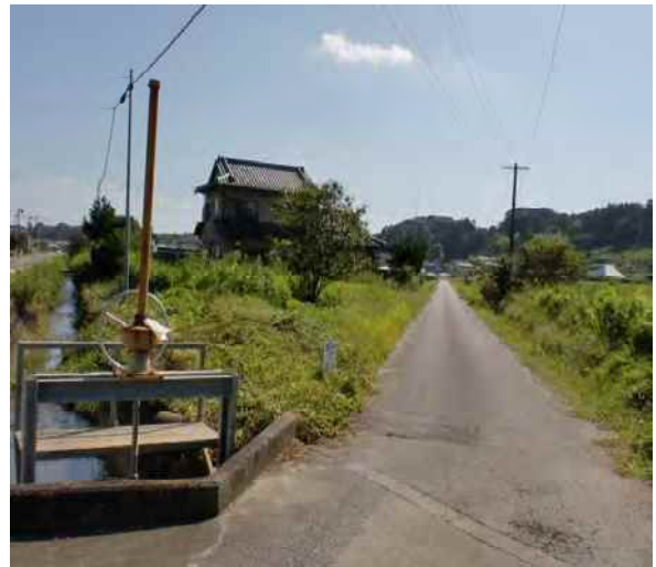
県道 81 号線 最福寺入口から南西方向
