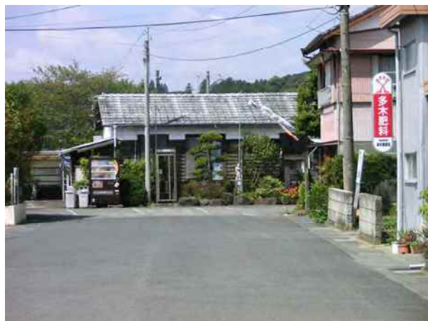
天浜線原谷駅舎
