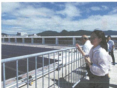
屋上に設置されたソーラパネル
