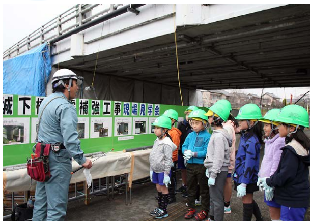
▲耐震補強工事の説明を受ける児童たち（右）
