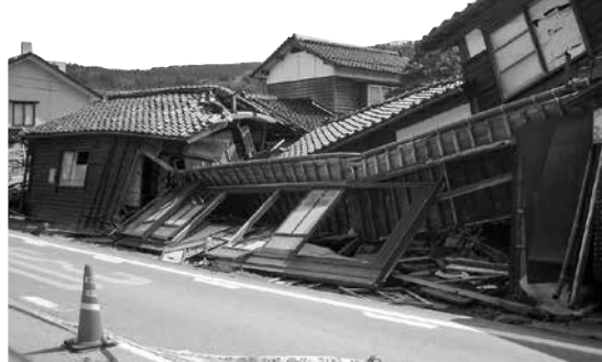
熊本地震で倒壊した家屋
