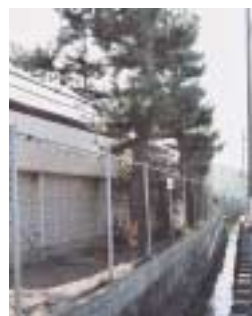
掛川西高テニスコート西側の土塁跡
