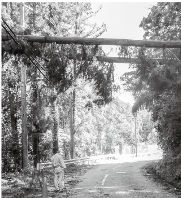
▲台風24号は風速40%超を記録。予想だにしない事態が次々に起こり市内各地で倒木や飛来物が配電線を断線した。
