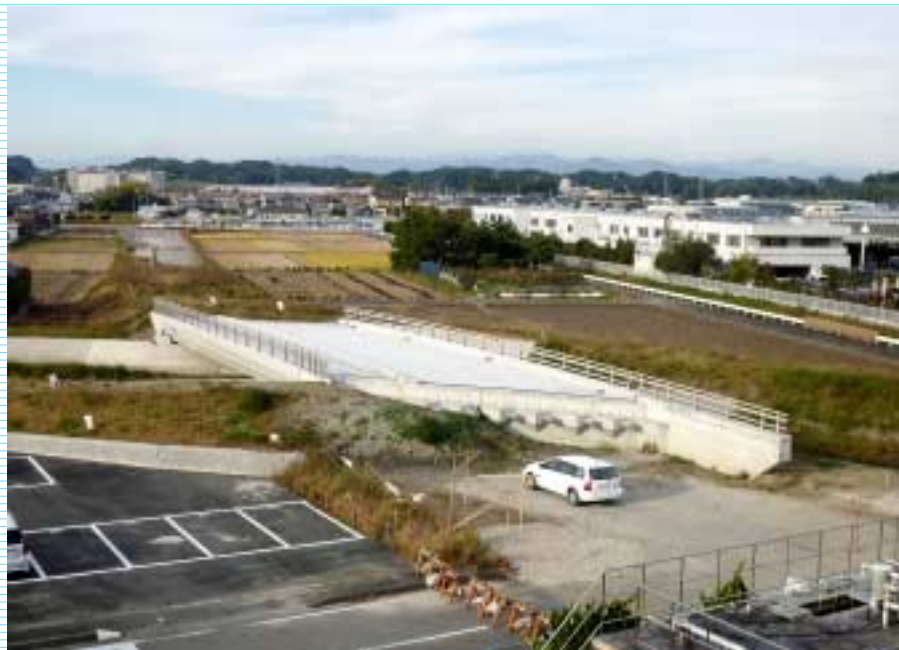
工事が進む県道相良大須賀線バイパス(かめっ子橋)
