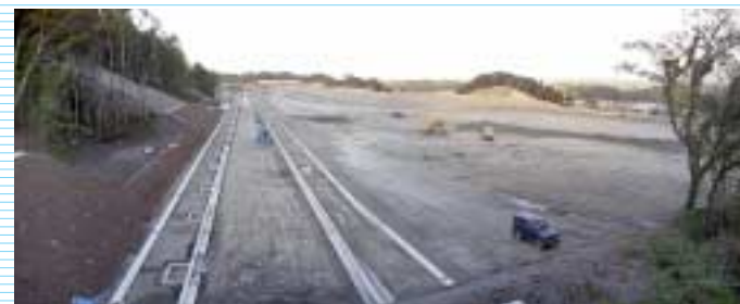
造成完了間近の新エコポリス第2期工業団地
