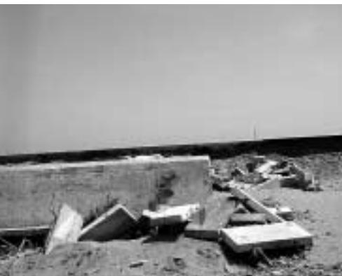
防潮堤が津波で破壊された遠州灘と類似した名取海岸
