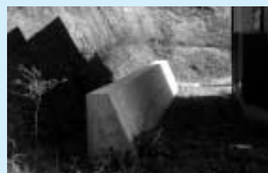
▲防土壁（擁壁）の設置例
