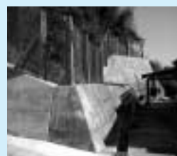
▲急傾斜地崩壊危険区域の県による対策工事例
