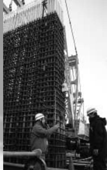
▲浜岡原発防波壁工事現場視察(2月8日)
