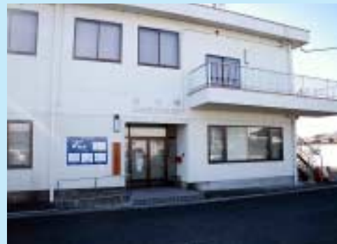
▲大須賀第三地区センターと同じフロアに設置(大須賀支所南館)
