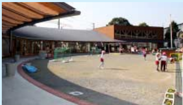
▲木が多く使われた新園舎
