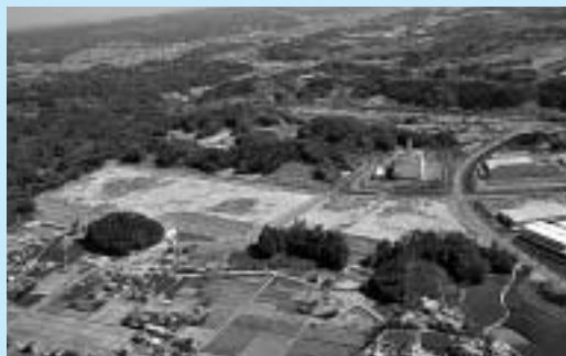
造成中の新エコボリス
