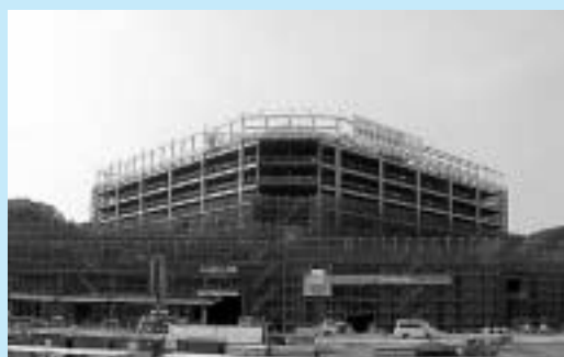
建設中の新病院「中東遠総合医療センター」
