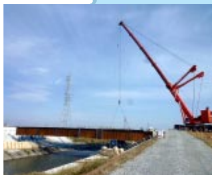
▲(都) 海洋公園線の牛淵川新橋架設の様子
