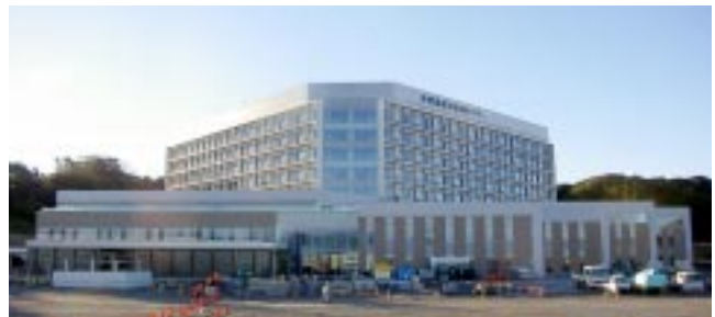
▲本体工事が完成した中東遠総合医療センター
