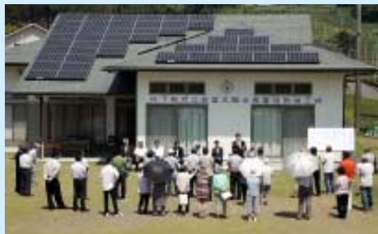
▲太陽光発電施設が設置された「下板沢公会堂」
