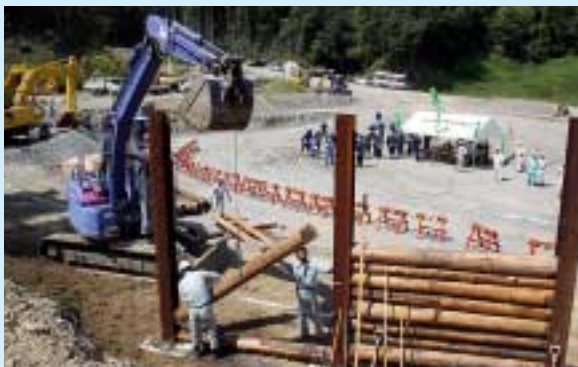
▲道路復旧訓練の様子
