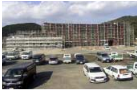
▲建設工事が進む(仮称)南部体育館(平成26年4月オープン予定)
