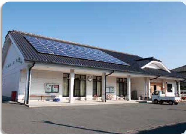
▲太陽光発電施設を設置した沖之須コミュニティセンター「いこい」
