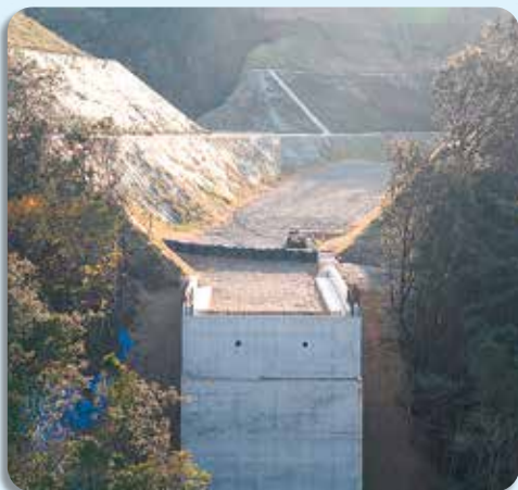
▲建設が進む市道入山瀬線
