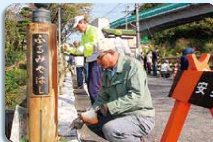
▲日坂地区で行われた協働による橋の塗り替え
