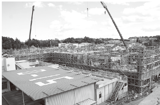
平成 27 年度末の完成を目指し工事が進む 中央消防署（右側奥、左側は現消防庁舎）
