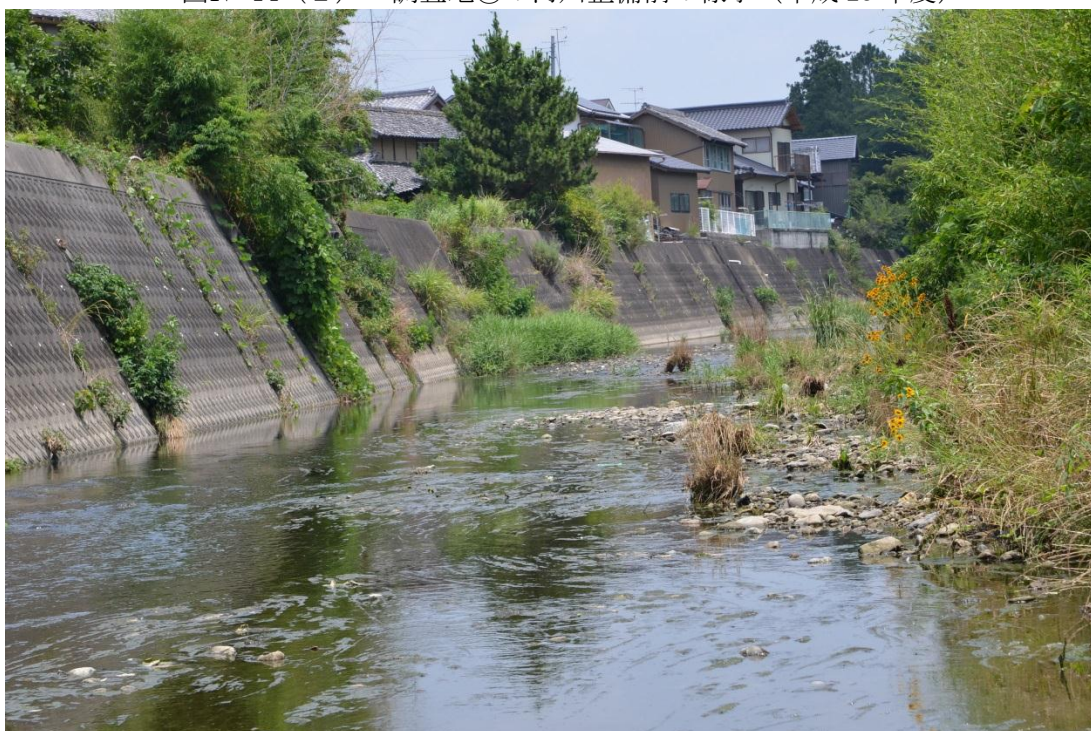
図IV-14（3） 調査地⑥の河川整備後の様子（平成 26 年度）
