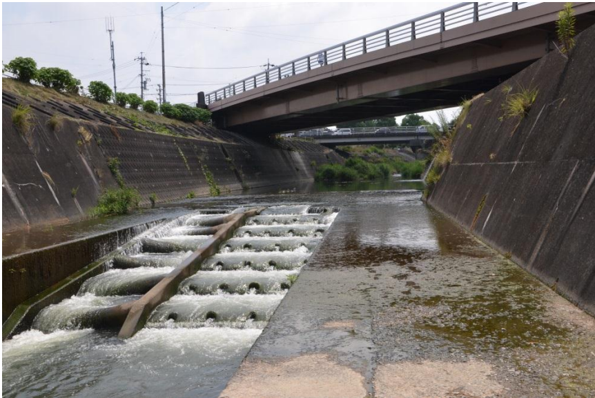
図IV-12 魚道がついた調査地④の堰堤
