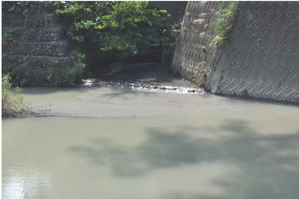
図IV-12 逆川への白濁水の流入地点
