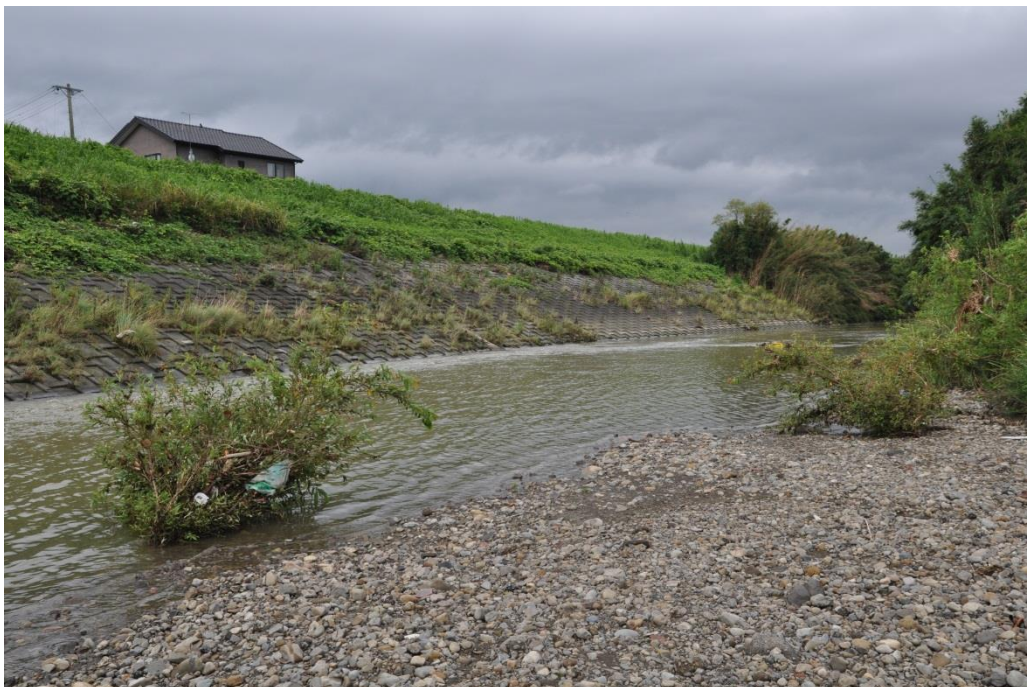
図Ⅲ-11 平成 24 年の調査地①の状況
