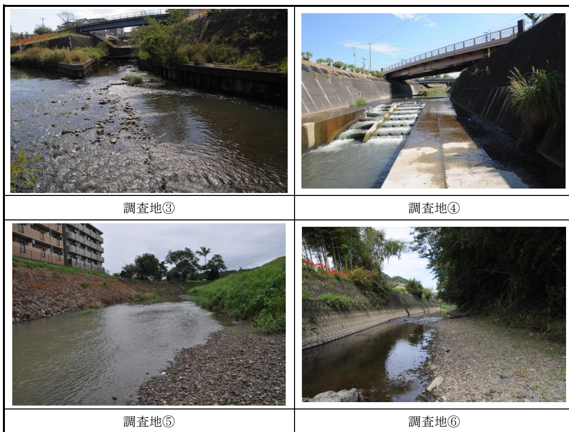
図Ⅲ-3 (2) 調査地の状況
