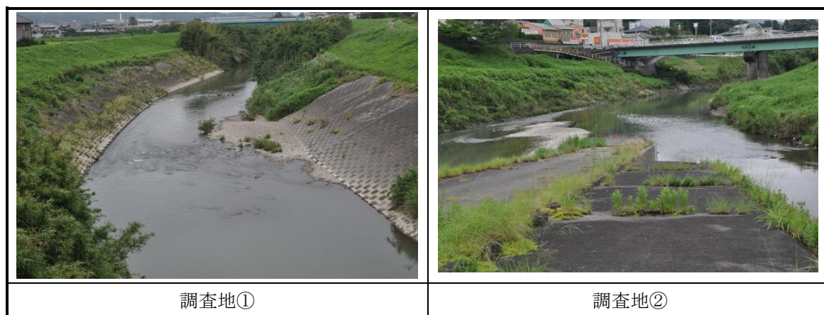
図Ⅲ-3 (1) 調査地の状況
