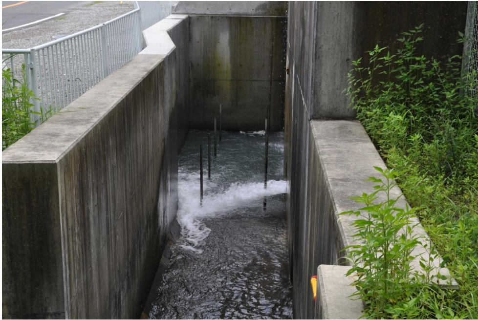
図Ⅲ-15 平成 24 年の大井川農業用水の放流口
