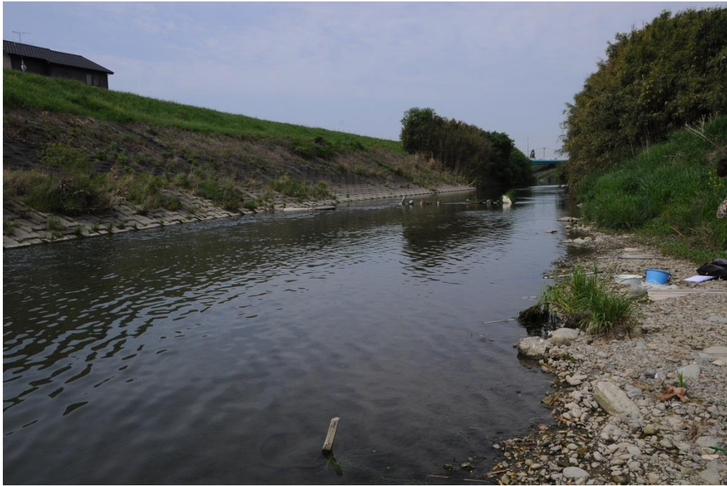
図Ⅲ-10 平成 23 年の調査地①の状況
