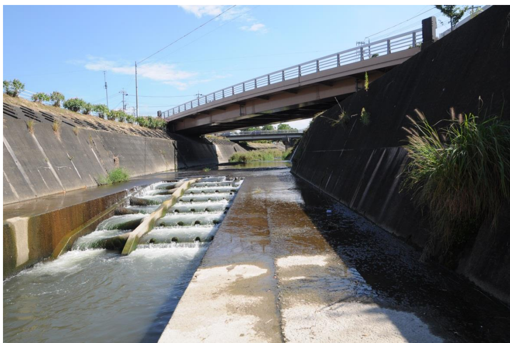
図Ⅲ-9 魚道がついた調査地④の堰堤
