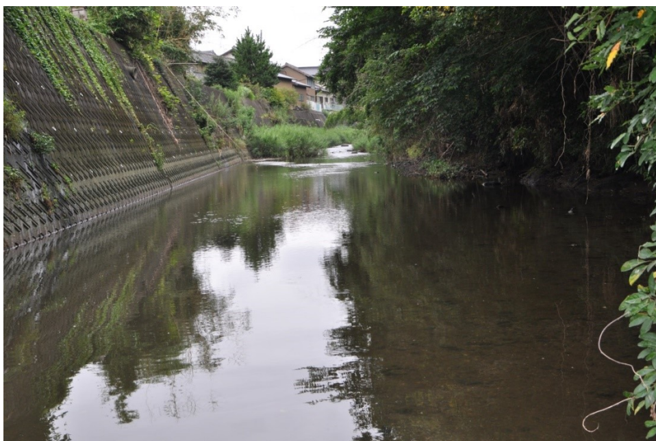
図V-7（2） 調査地⑥の河川整備前の様子（平成25年度）
