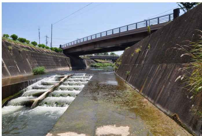
魚道がついた調査地④の堰堤
