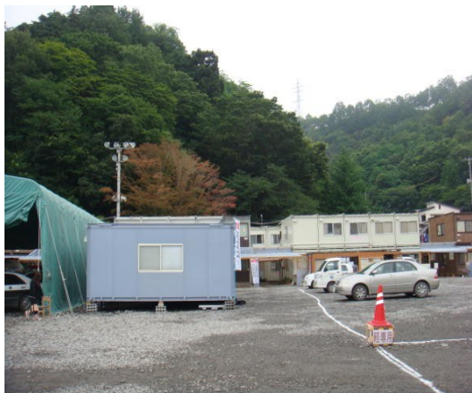
仮設の大槌町役場 (大槌町役場が津波被害で使用できないため大槌小学校に設置)
