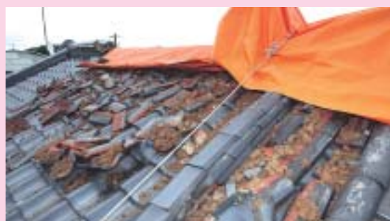
屋根瓦の落下の様子
